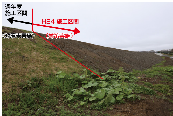
写真-3 堤防の状況
