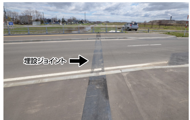
写真-4 路面状況(近接橋梁)
