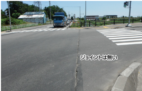
写真-2 路面状況(雁来5号橋)
