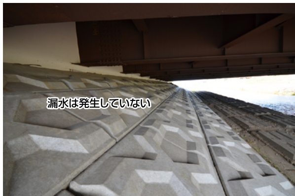
写真-3 桁下状況(雁来5号橋)
