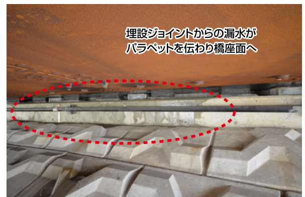
写真-5 桁下状況(近接橋梁)
