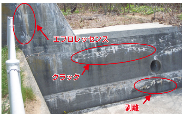
写真-1 えん堤の劣化状況
