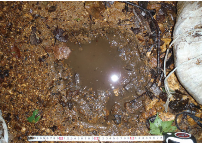
写真-6 土のう下の状況
