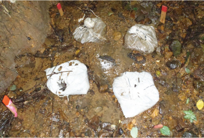
写真-5 設置した土のうの状況
