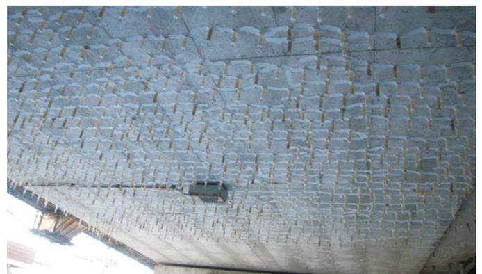
写真-1 ひび割れ注入工法
