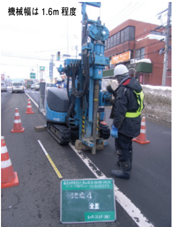
写真-1 ボーリングマシン (二重管工法)
