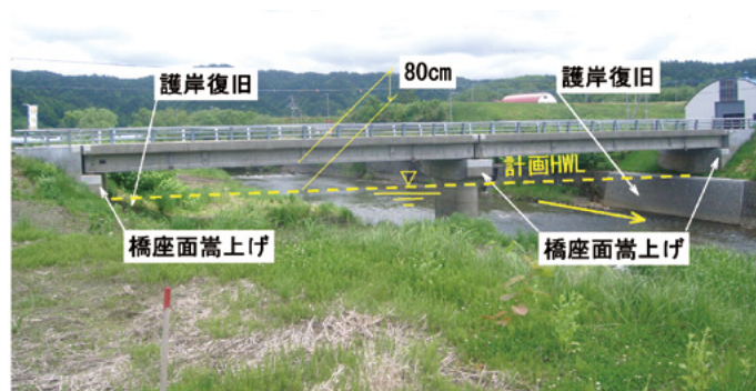
写真-2 竣工後橋梁状況 下流から橋梁を望む
