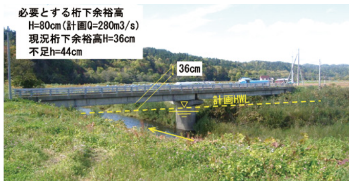
写真-1 竣工前橋梁状況 上流から橋梁を望む
