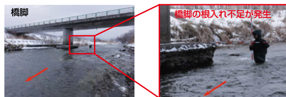
写真-2 橋梁と橋脚の根入れ不足の様子
