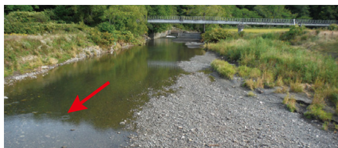
写真-3 河床低下区間より上流の様子
