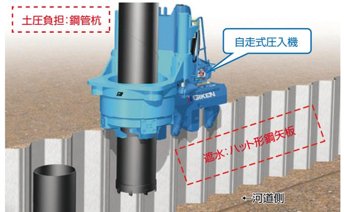
図-4 コンビジャイロ工法の概念図 (株)技研製作所 提供
