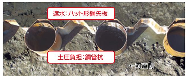
図-5 ハット形鋼矢板と鋼管杭の配置上面図 (株)技研製作所 提供
