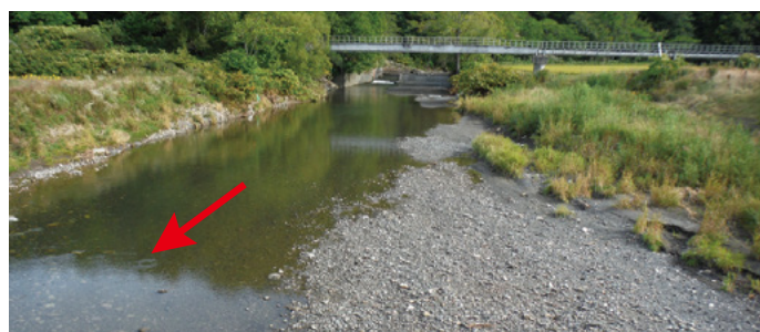
写真-3 河床低下区間より上流の様子
