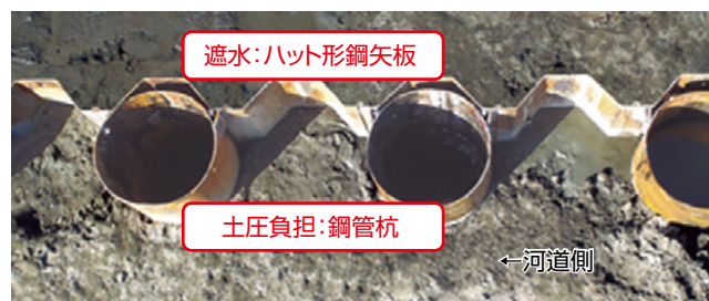
図-5 ハット形鋼矢板と鋼管杭の配置上面図 (株)技研製作所 提供
