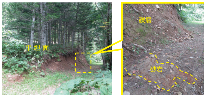
写真-2 対岸斜面の露頭状況(写真奥が地すべり地)
