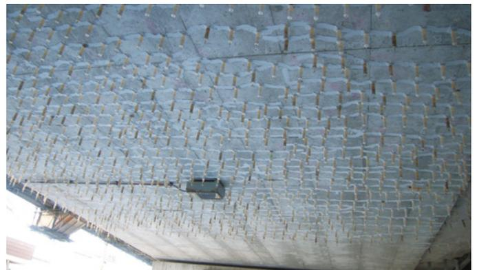
写真-1 ひび割れ注入工法
