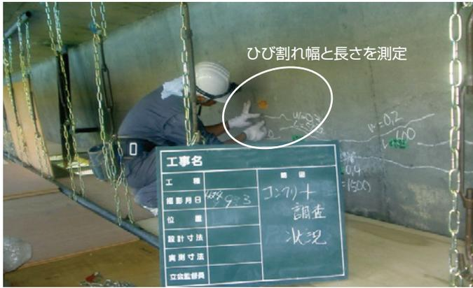
写真-2 施工前のひび割れ調査状況
