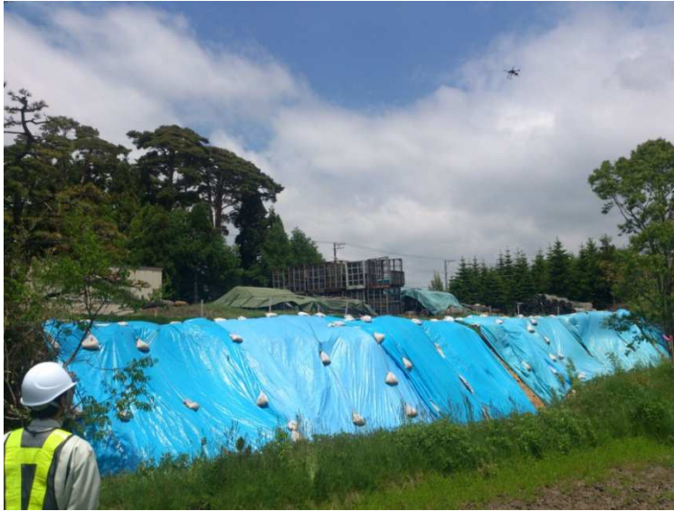
写真-UAVによる空中写真撮影風景
