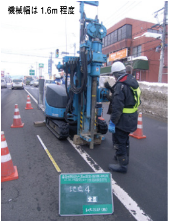
写真-1 ボーリングマシン (二重管工法)
