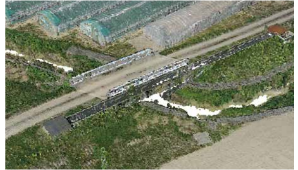
図-3 構造物の点群
