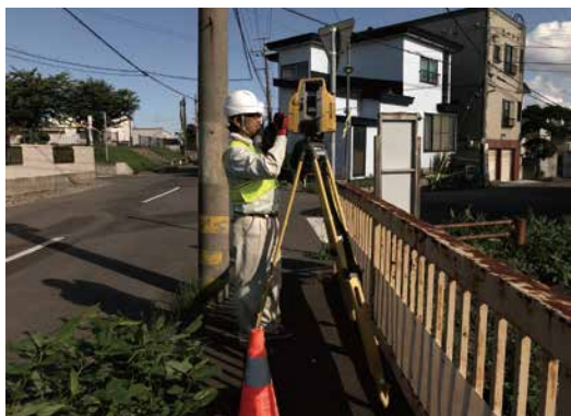
写真-2 地上レーザ計測
