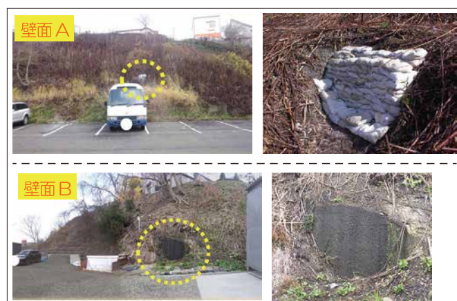
写真-2 斜面下部で確認した2箇所の「壁面A・B」
