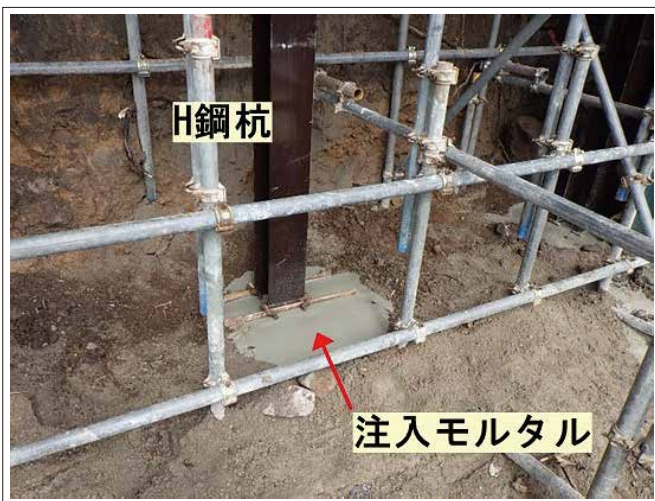
写真-3 注入モルタル状況
