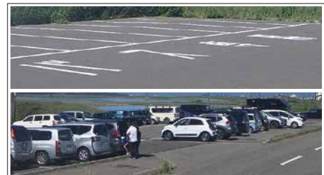
写真-3 駐車場の状況
