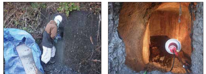
写真-6 防空壕跡Bの調査状況(はつり、開口状況)
