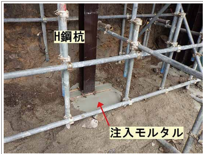
写真-3 注入モルタル状況
