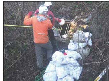
写真-5 防空壕跡Aの調査状況
